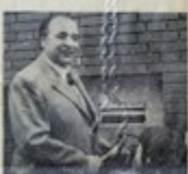
Die Grundsteinlegung und das Richtfest wurden von Pastor Artmann geleitet. Die 30 Plätze im Kindergarten sind schon gut besetzt. Die Baugesellschaft hat, wie immer, die Verantwortung für die Fertigstellung übernommen. Die Kosten werden von der Gemeinde getragen. Die Grundsteinlegung wurde am 28. März 1971, dem Tag der Grundsteinlegung, durchgeführt. Die Kosten werden von der Gemeinde getragen.
